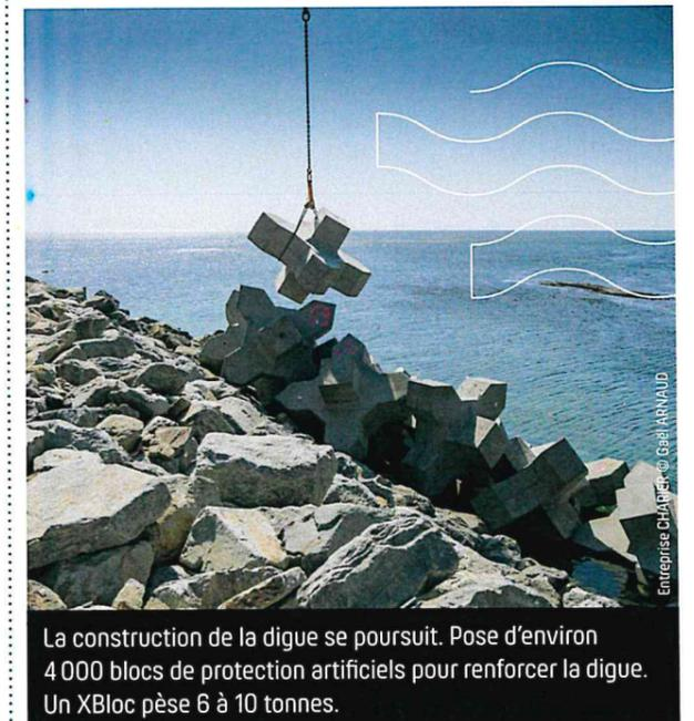
La construction de la digue se poursuit. Pose d'environ 4 000 blocs de protection artificiels pour renforcer la digue. Un XBloc pèse 6 à 10 tonnes.
