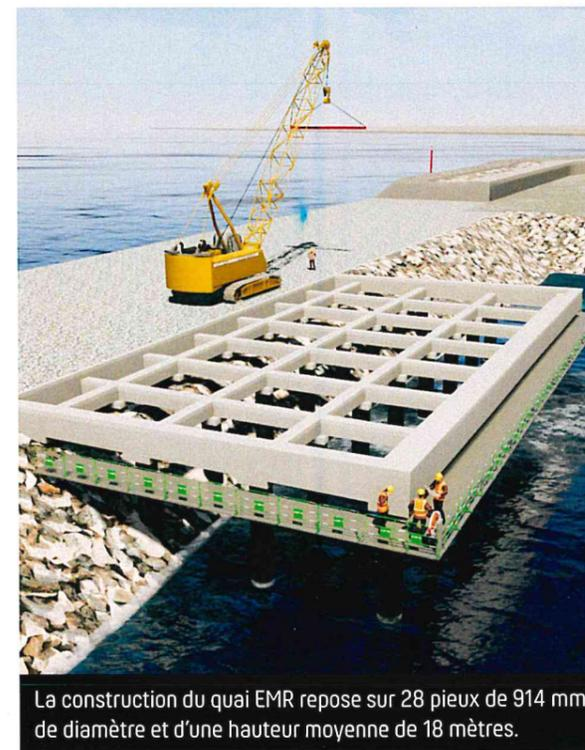
La construction du quai EMR repose sur 28 pieux de 914 mm de diamètre et d'une hauteur moyenne de 18 mètres.
